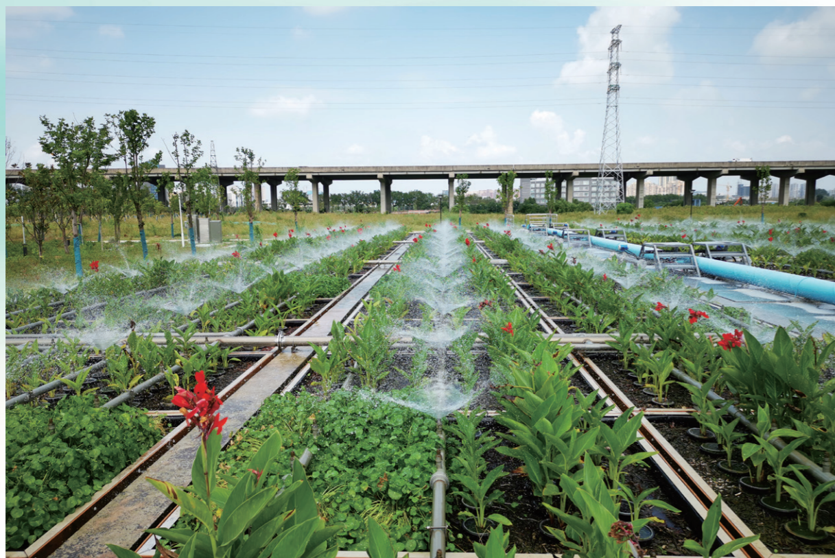
中国煤科南京设计院江宁科学园污水厂尾水提标及生态修复整治项目
